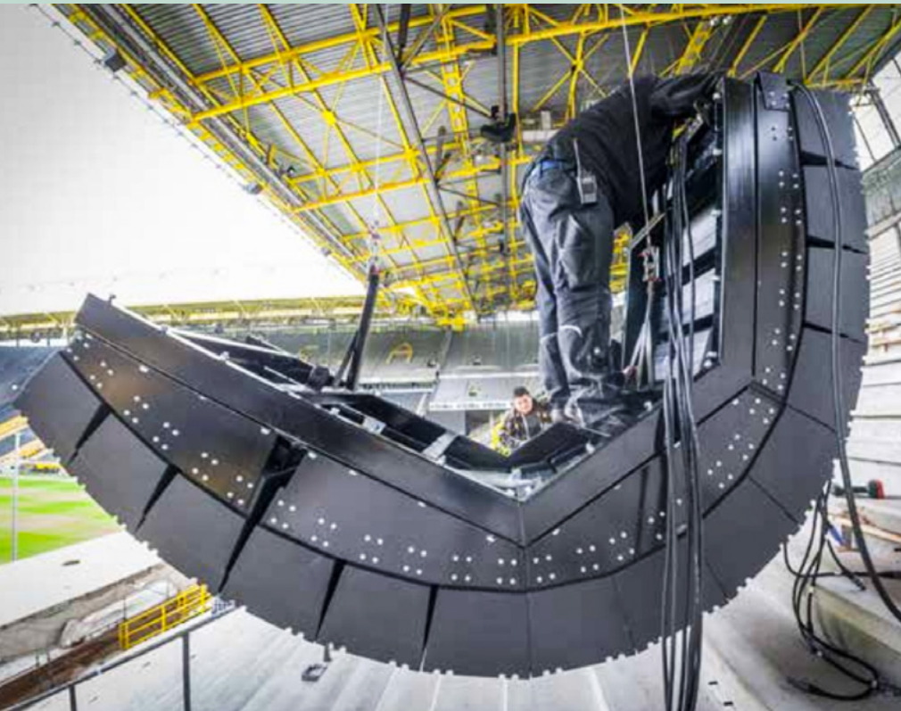
Abbildung 13: Line Array mit progressiver Krümmung im Stadion (Nahansicht).
