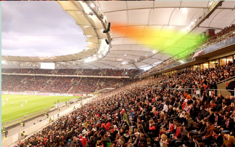
Abbildung 8: Typische Abstrahlcharakteristik im Schnitt (Tribüne – Oberrang)
