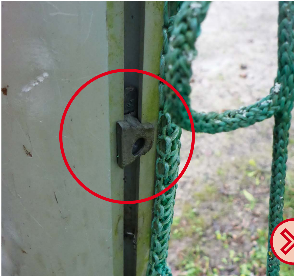
Bild 31: Gebrochene Kunststoffnetzaken sind auszutauschen.
