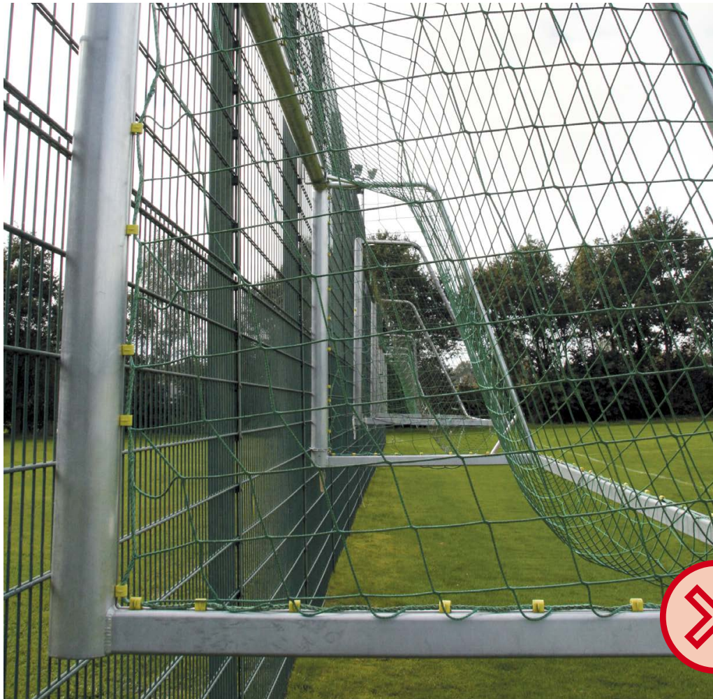
Bild 42: Mehrere Tore am Ballfangzaun
