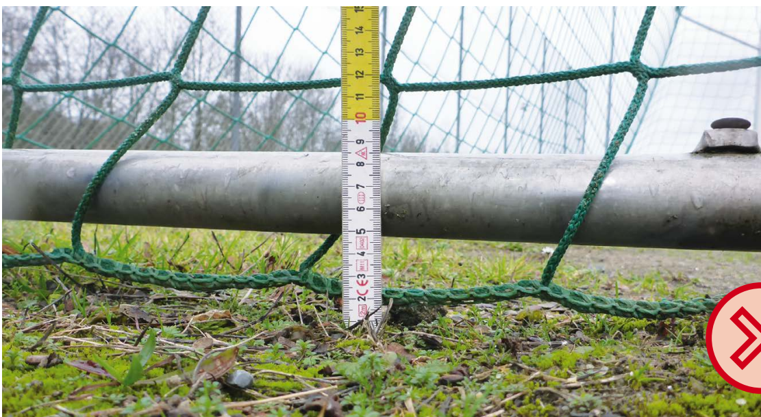
Bild 23: Höhendifferenz zwischen Bodenrahmen und Boden
