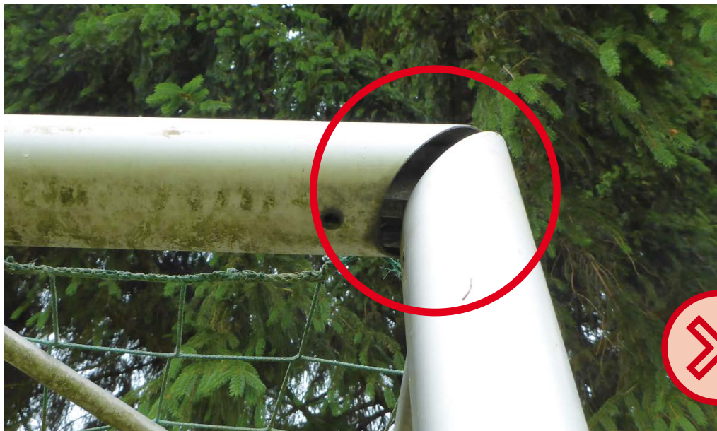
Bild 11: Hier fehlen Schrauben, so dass Pfosten und Torlatte nicht mehr fest miteinander verbunden sind.
