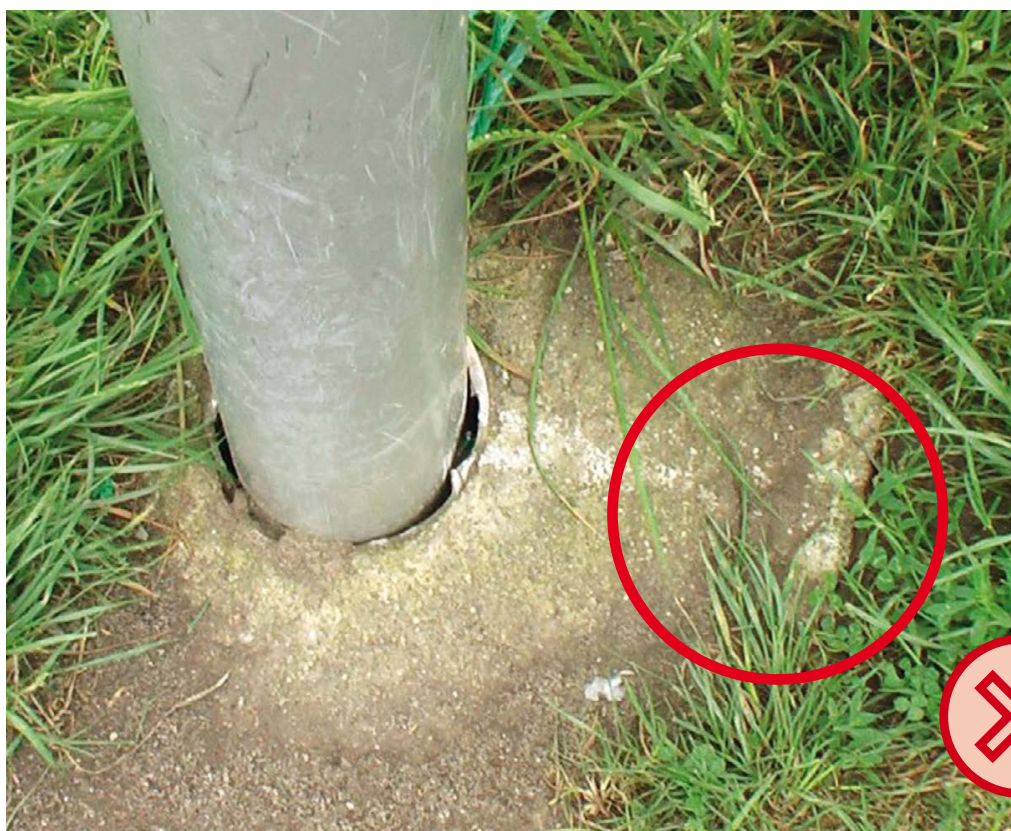
Bild 24: Fundamente sind mind. 4 cm zu überdecken
