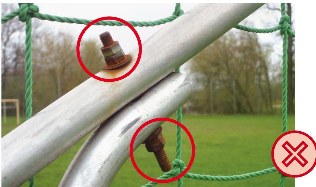
Bild 18: Überstehende Schrauben
