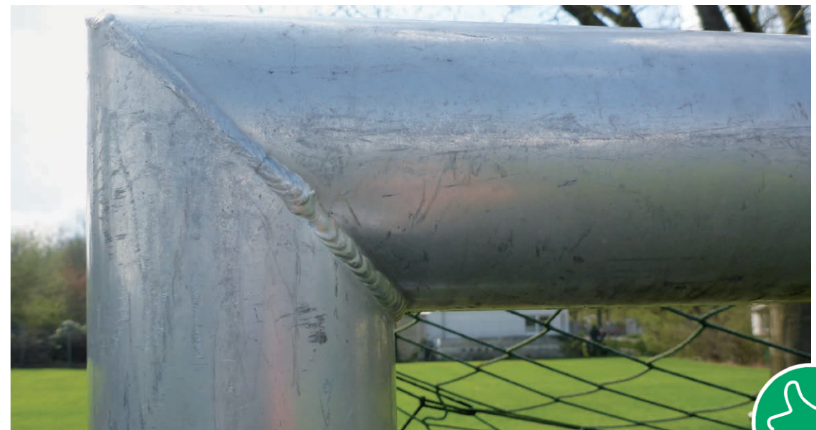
Bild 14: Pfosten und Querlatte haben den gleichen Querschnitt
