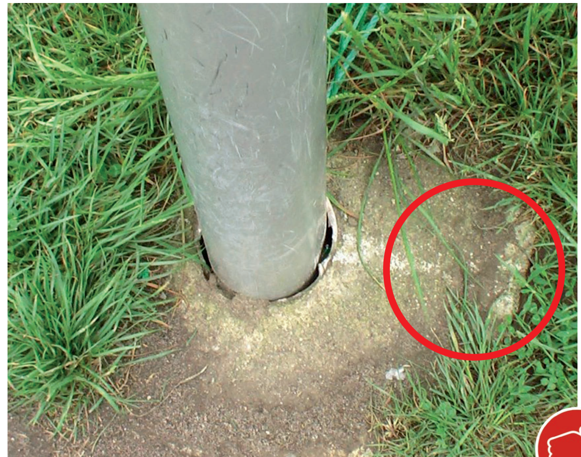
Bild 25: Fundamente sind mind. 4 cm zu überdecken
