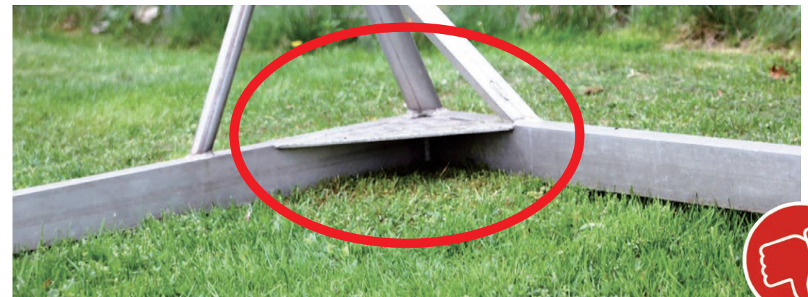
Bild 28: Eingeschweißter Winkel stellt erhöhte Verletzungsgefahr dar
