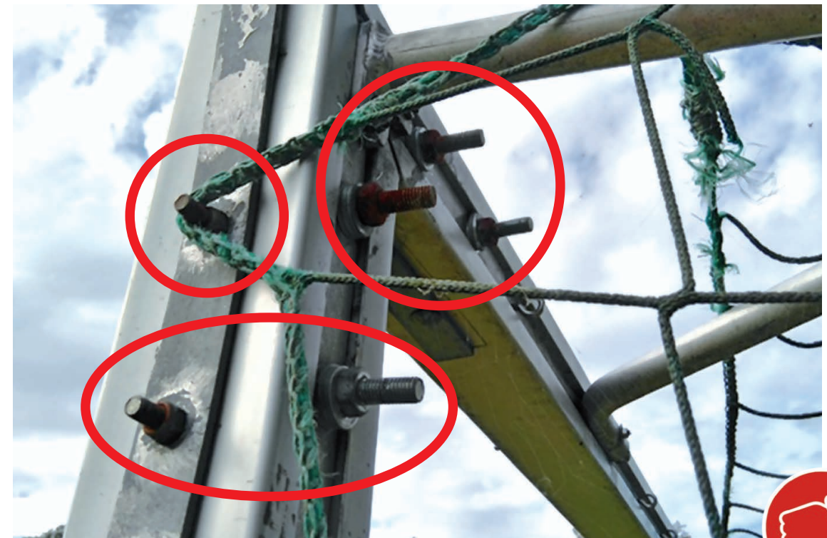
Bild 17: Überstehende Schrauben an Pfosten und Querlatte
