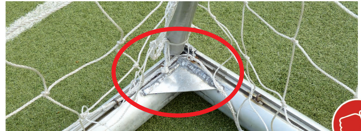
Bild 28: Eingeschweißter Winkel stellt erhöhte Verletzungsgefahr dar
