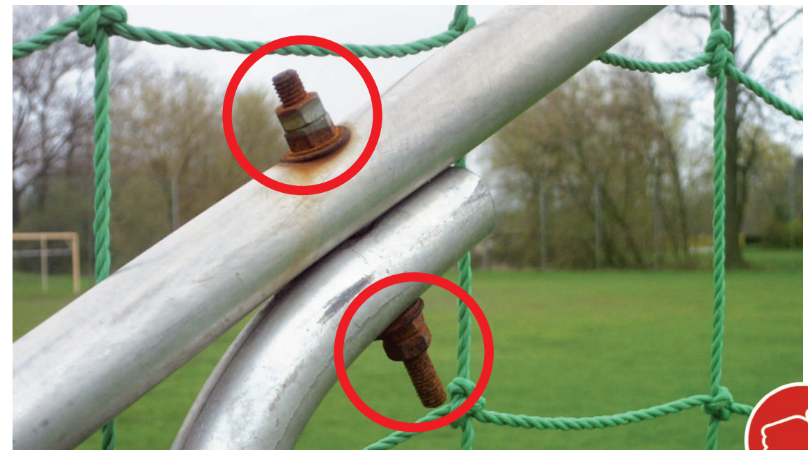
Bild 18: Überstehende Schrauben
