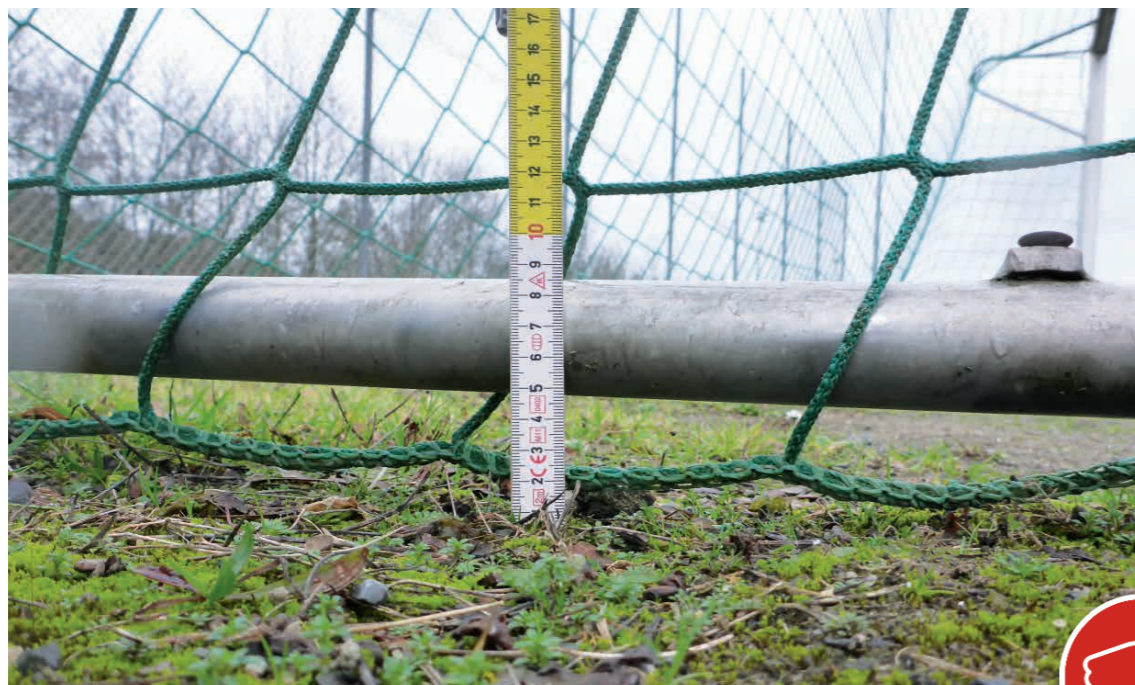
Bild 24: Höhendifferenz zwischen Bodenrahmen und Boden
