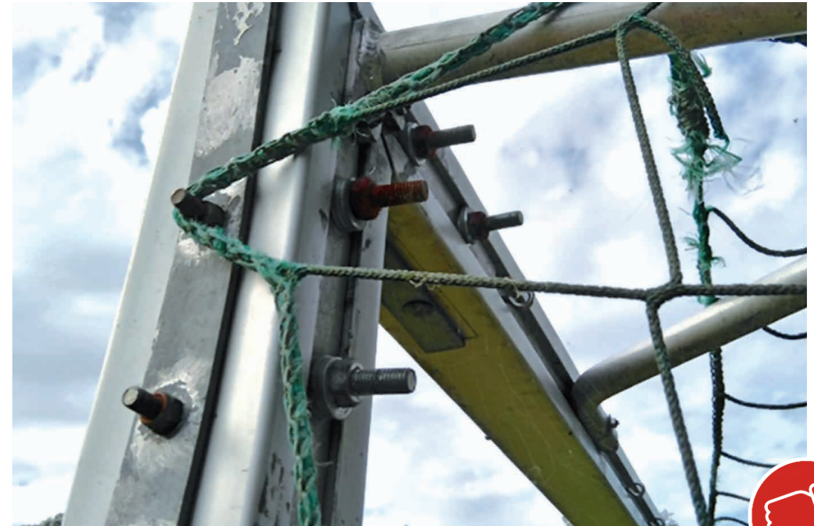
Bild 17: Überstehende Schrauben am Pfosten und Querlatte
