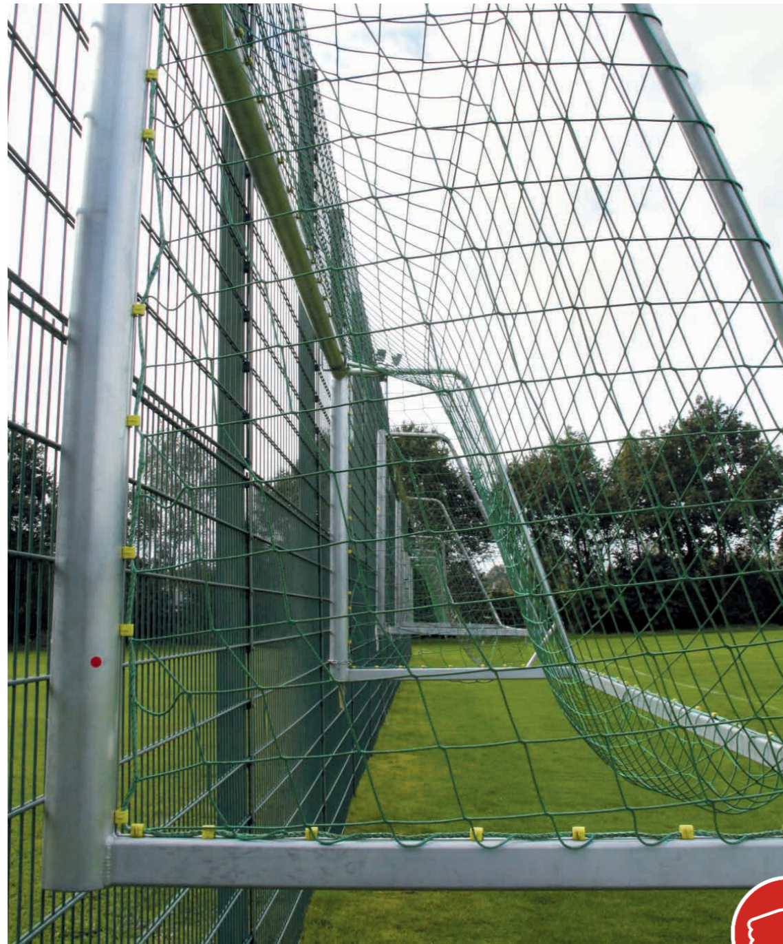
Bild 43: Mehrere Tore am Ballfangzaun
