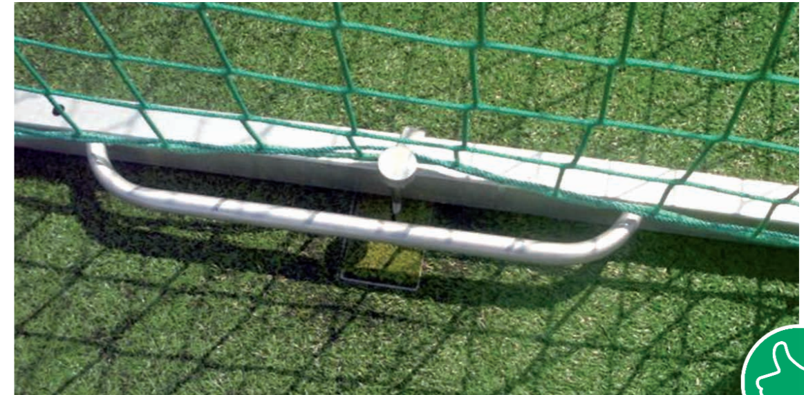
Bild 3: Tor-Typ 3 mit Bodenbefestigung, hier: Spiralanker bei der Sportgeräteinspektion vor Ort. In diesem Fall wurden die Anforderungen an Standfestigkeit und Festigkeit gemäß DIN EN 748 erfüllt.
