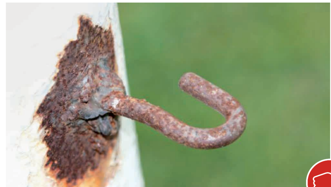
Bild 32a, 32b: Offene Metallnetzhaken sind nicht erlaubt.
