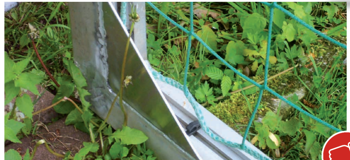
Bild 29a, 29b: Horizontal und vertikal eingeschweißte Winkel stellen erhöhte Verletzungsgefahren dar.
