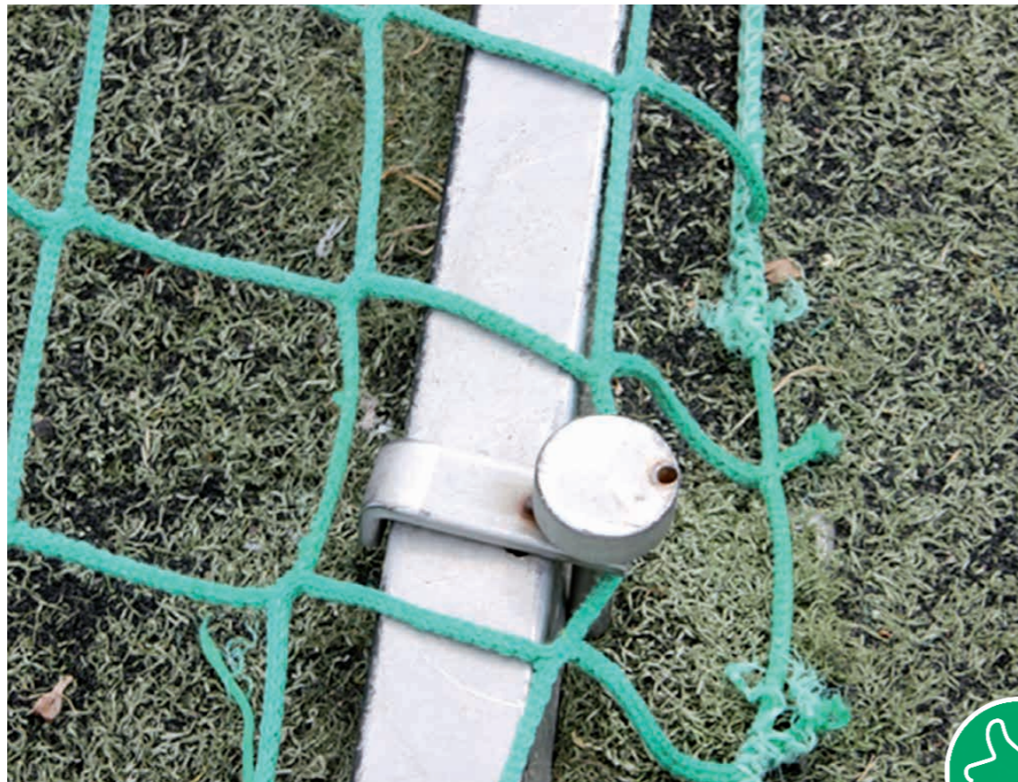
Bild 8: Befestigung mit Klemmbodenhülsen
